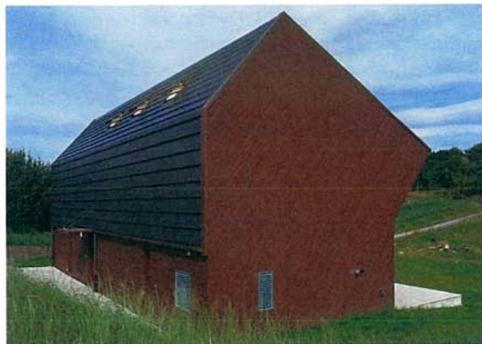
Drei Elemente bilden die Außenhaut des Hauses: Glas vor allem an der Vorderfront, Tannenholz und Tondachziegel für Fassade und Dach.
